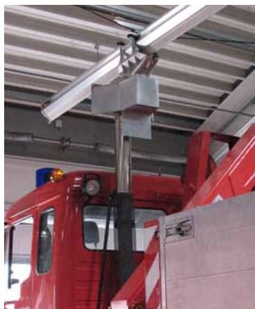
Seitenverschiebbare Absaughaube für oberliegenden Auspuff.
