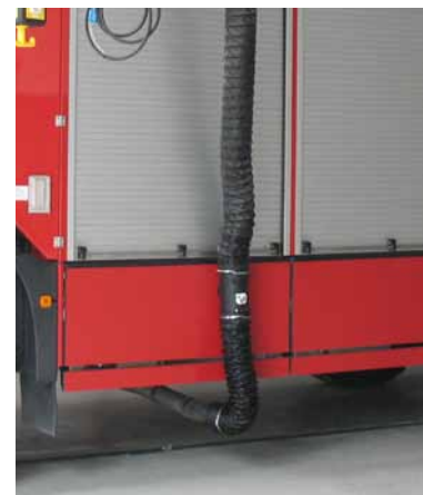
Magnetgekoppelter Abgas-trichter in aufgehängtem Schlauch.
