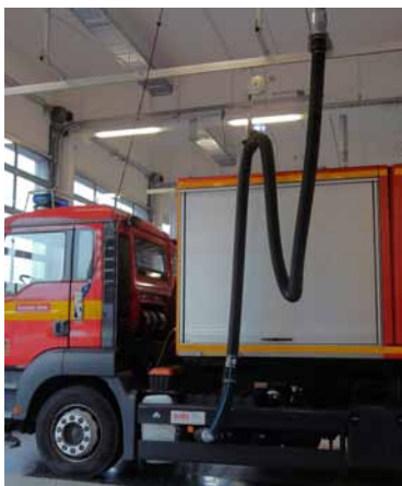
Pneumatisches Mundstück mit abgehängtem Schlauch.
